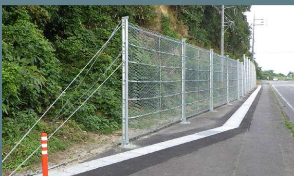
【法尻部】 道路への落石防止
