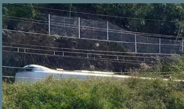
【中腹部】 線路への落石防止
