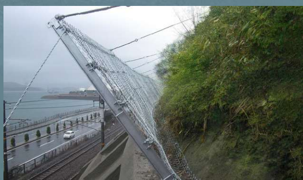
【法肩部】 線路への落石防止
